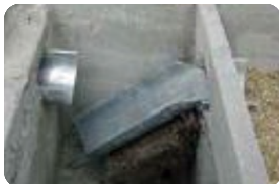
Figure 3 : Disconnecteur avant l'arrivée de la pluie
